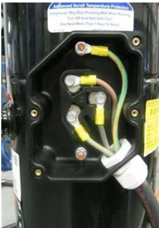
Рис 11: Правильное электрическое подключение клеммной коробки IP54 с помощью кабельных муфт
