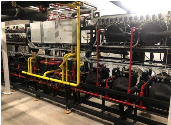
Рис. 3 Компрессорный агрегат производства Elementum для проекта Metro Солнцево.
